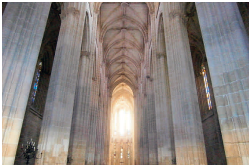
Batalha. Interior de l'església.
